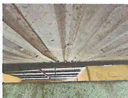
Foto 2: Espacio entre muro del aula y el techo de lámina para reparación y refuerzo de pared de salón
