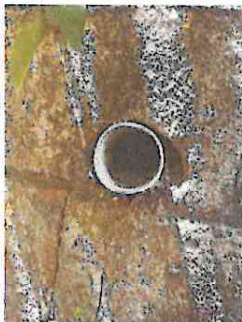
Foto 9: Respiradero de la fosa séptica
